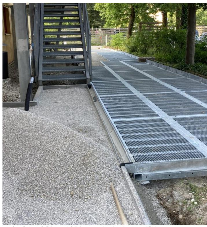
So sehen die Wurzelbrücken aus: Die Lebensadern der Bäume liegen geschützt unter einem Fundament-gestützten Gitterrost
