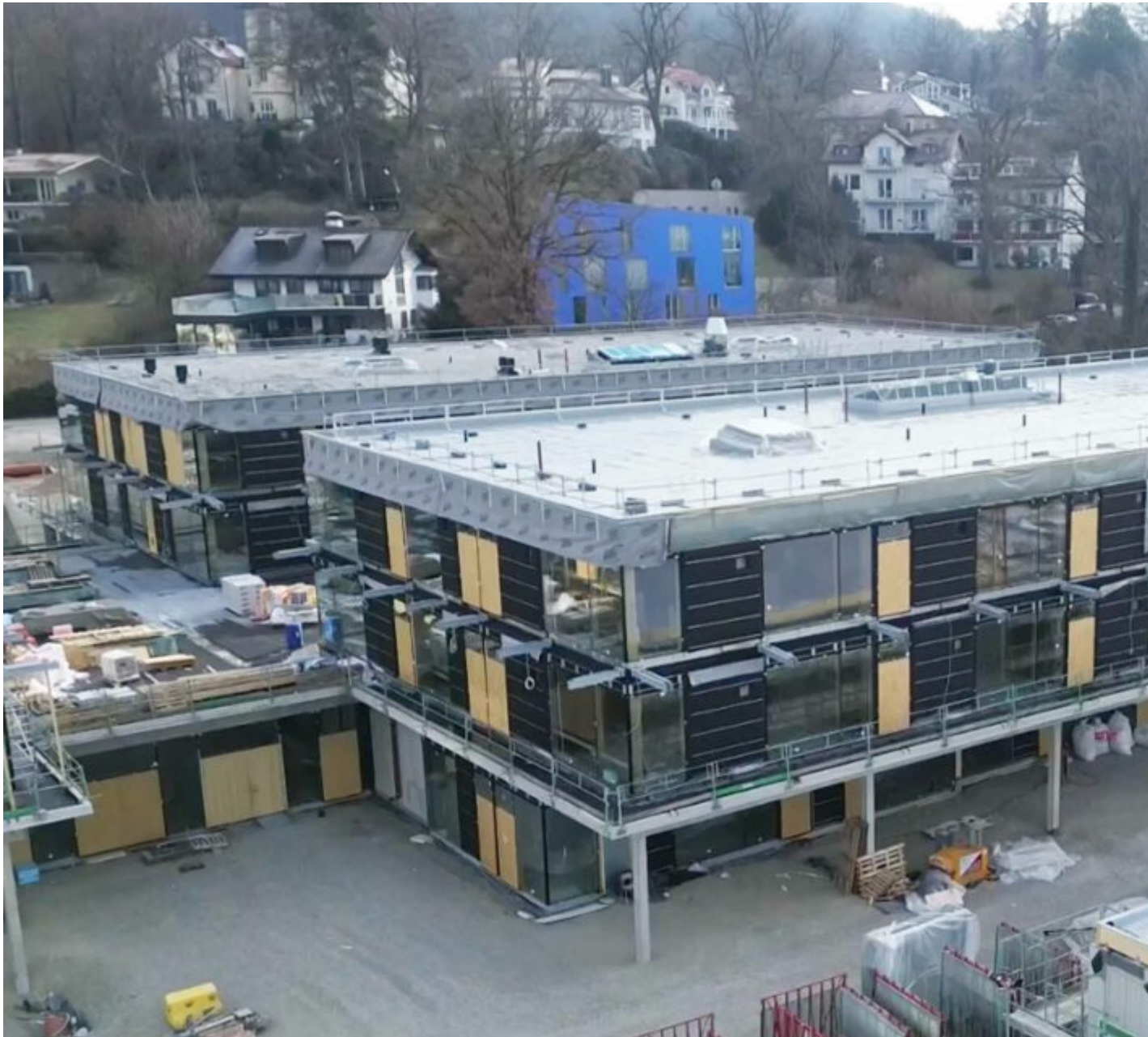
Filigrane Strukturen: Durch viel Glas und Holz wirkt der Bau feingliedrig. Foto: Landratsamt Starnberg
