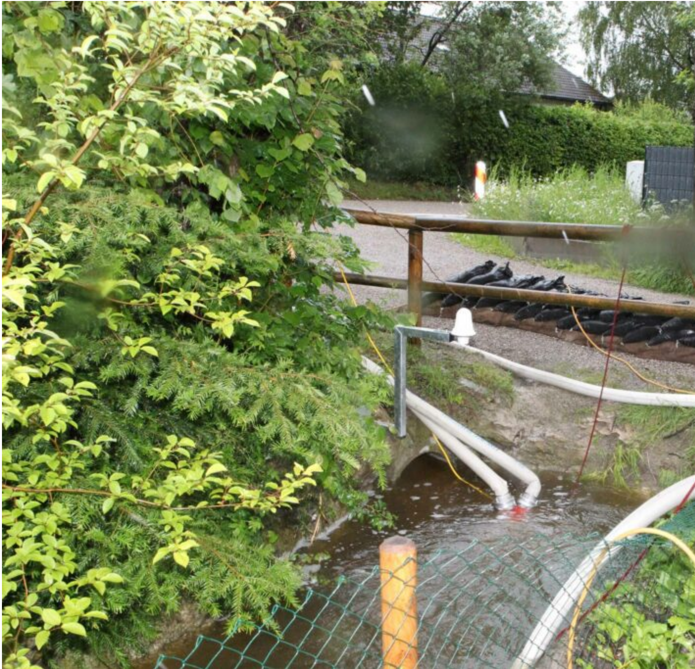
Damit der Fendlbach nicht überläuft, hat die Breitbrunner Feuerwehr Ende Mai Wasser umgeleitet. Auf der Stange über dem Bachbett sitzt ein Sensor, der den aktuellen Pegelstand an eine Info-Zentrale meldet.
