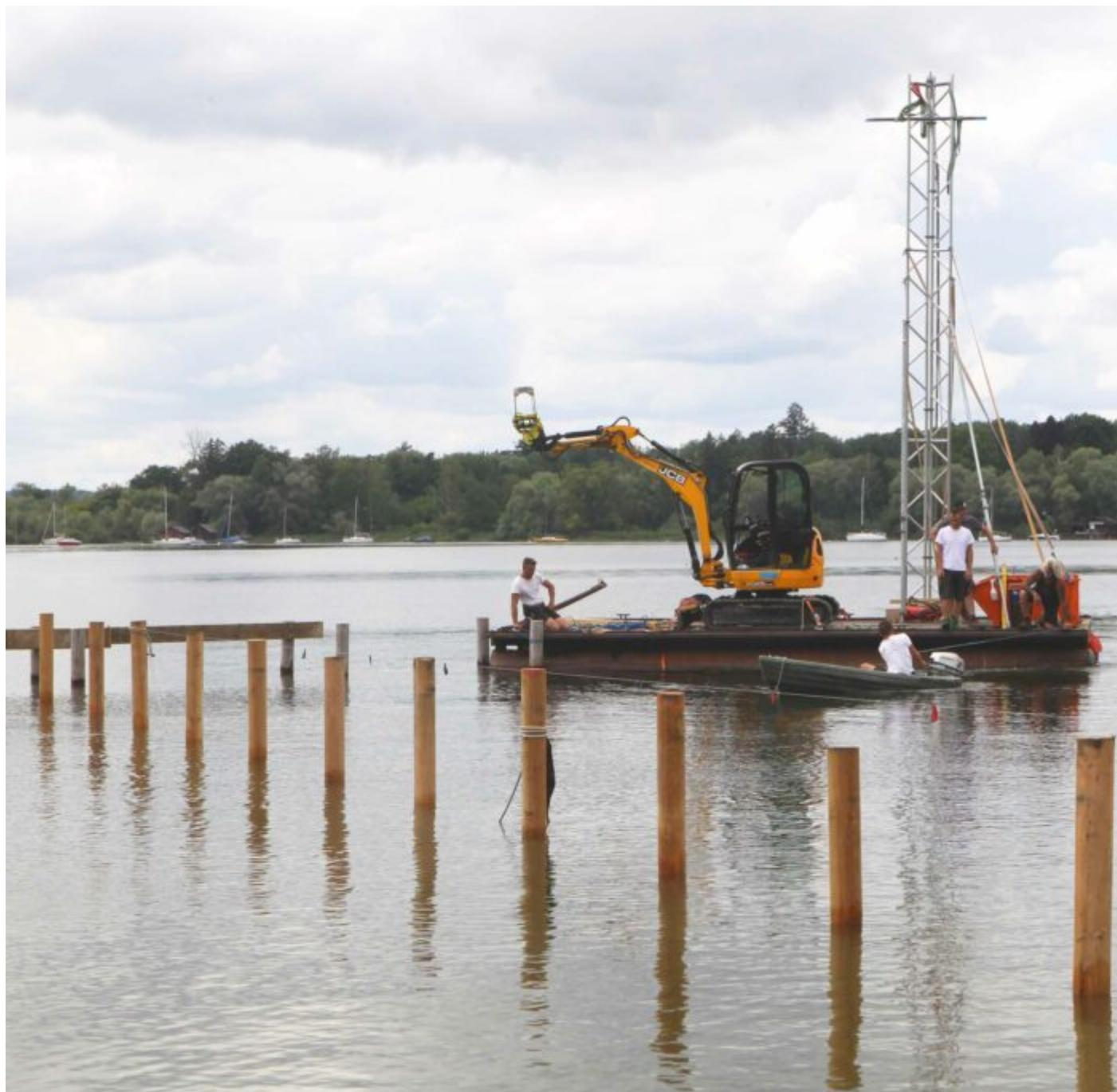
Ein Floß mit Rammturm versenkte die Balken im Uferuntergrund. Die Arbeiten waren aufwendig, weil der Seeboden durch das harte Sediment extrem viel Widerstand bot.
