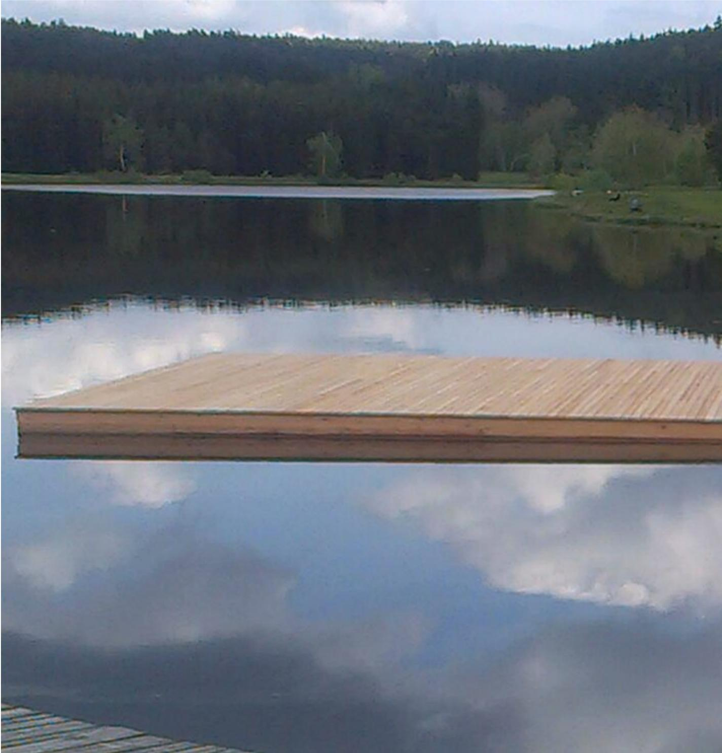
Eine schwimmende Badeinsel ohne Pfähle. Der Vorteil dieser Konstruktion ist ein niedriger Freibord – Schwimmer und Bootsfahrer können die Insel einfach entern. Foto: Hochstöger
