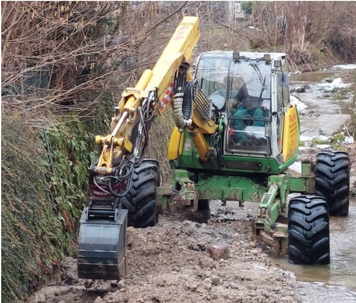
Ein Bächlein wird zur Großbaustelle: Ein Schreitbagger im Bachbett
