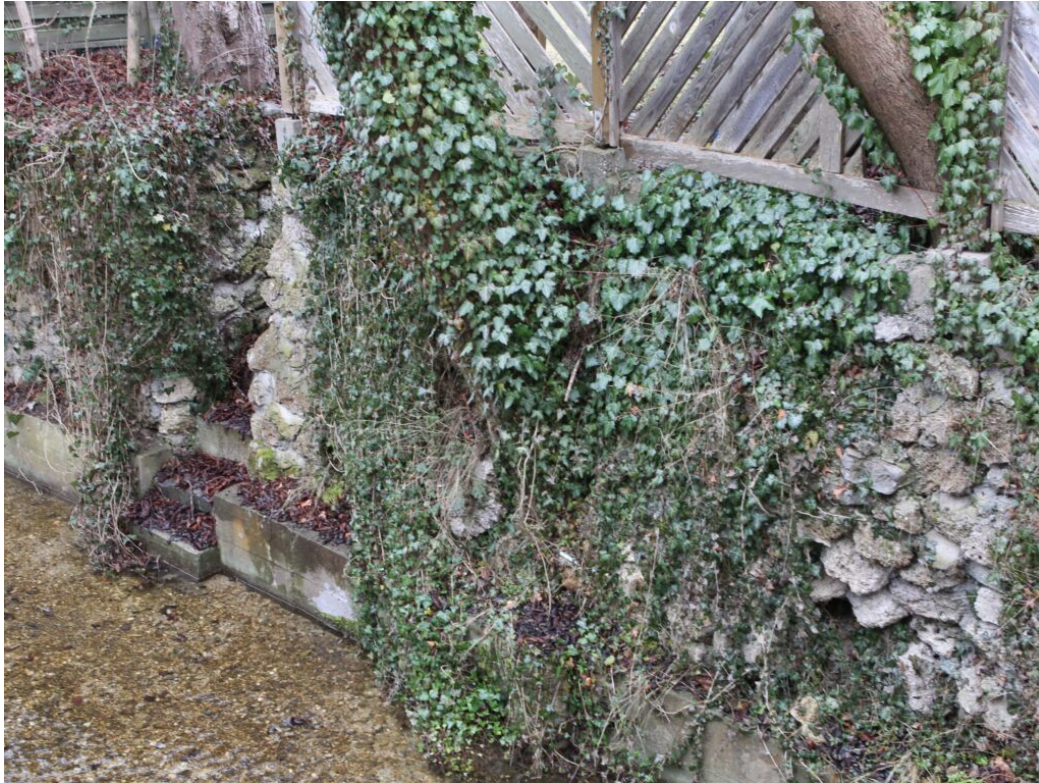
Die Ufermauern am Kienbach sind nicht wegen der Wurzeln marode
