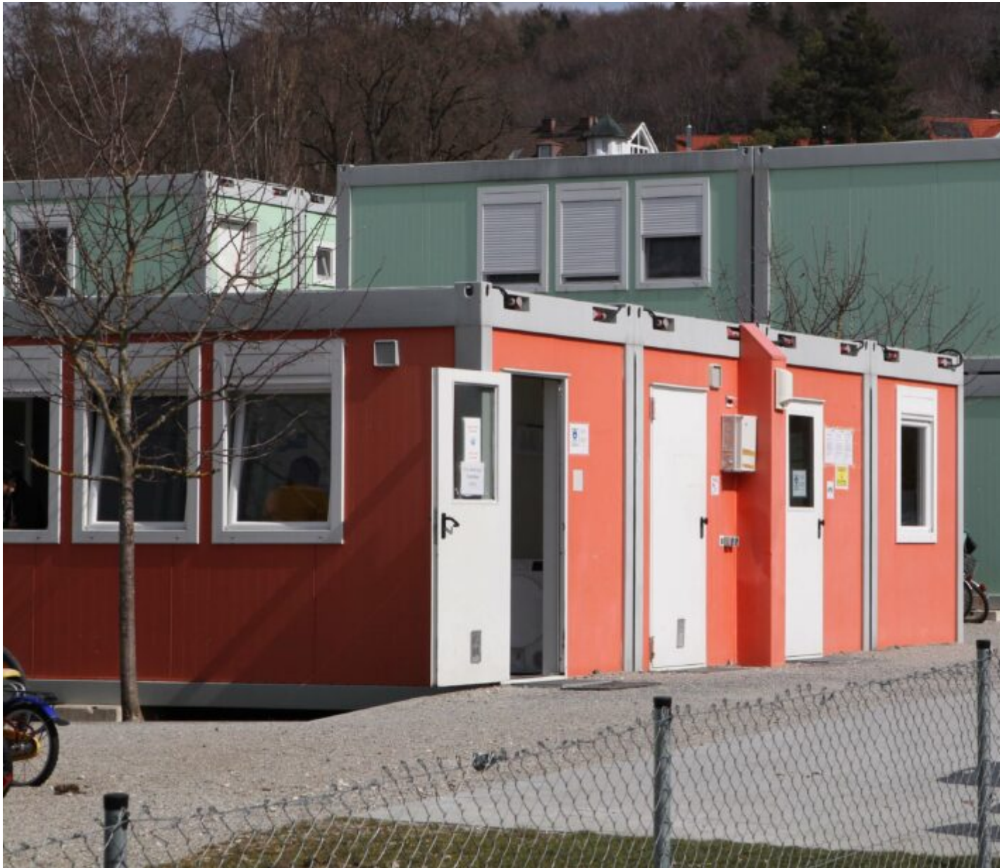
Das Asyl-Containerdorf an der Goethestraße. Hier leben 120 Geflüchtete, darunter 56 Kinder, in 18 Familien. Einige Asylbewerber sind schon seit 7 Jahren in Herrsching. Sie arbeiten, die Kinder gehen hier zur Schule, haben Freunde und sprechen Deutsch.
