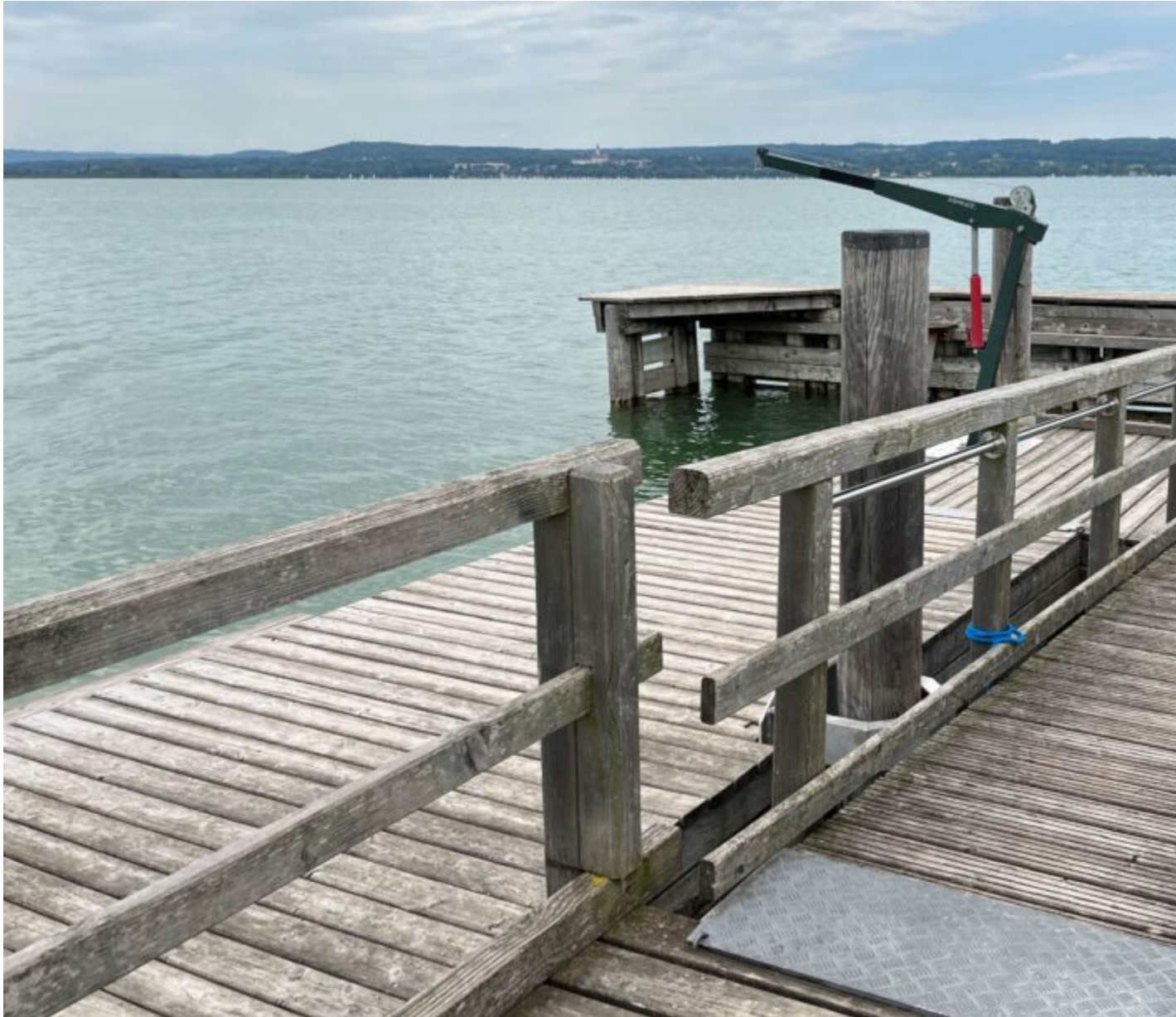
Sogar der Steg mit Seezugang wurde behindertengerecht konstruiert
