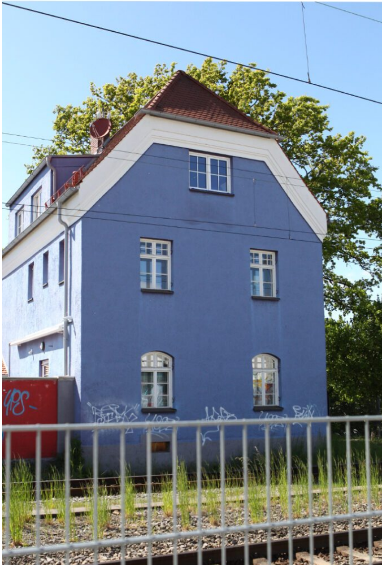
Stellwerk: Auch das Haus der Jugend trägt Graffiti-Spuren
